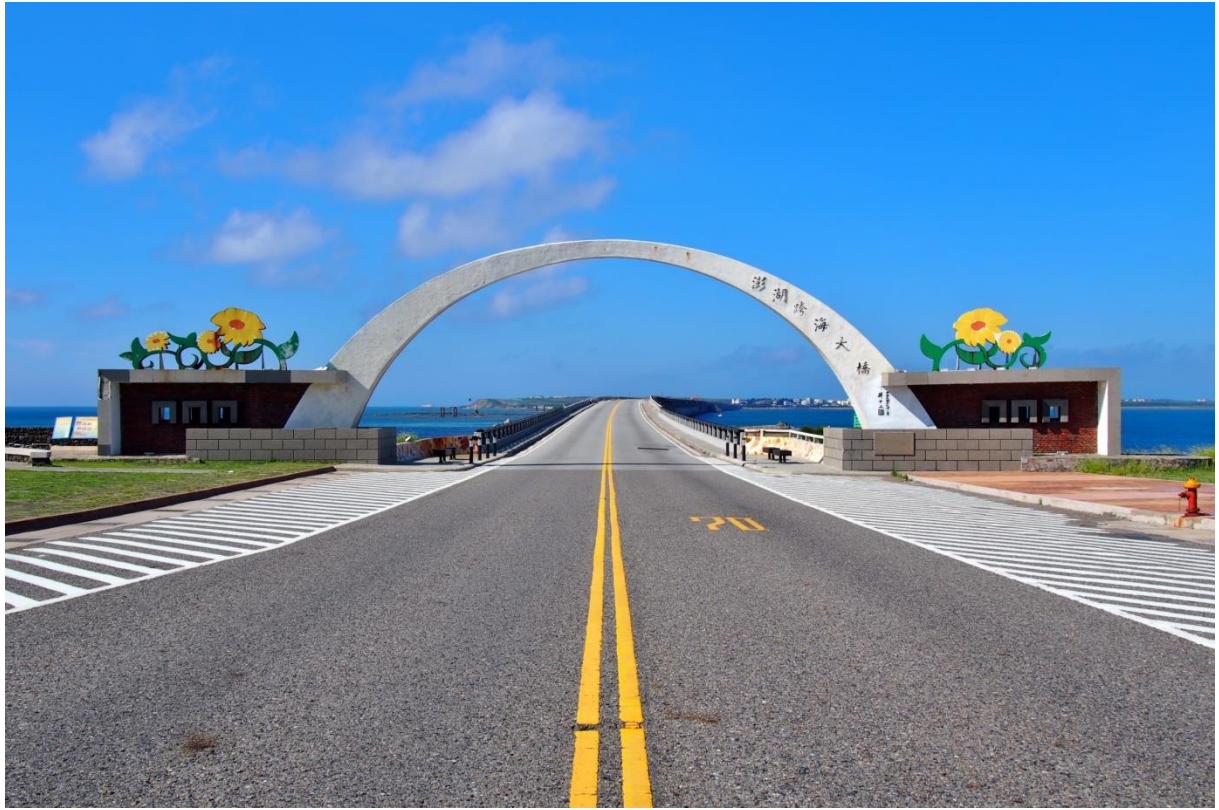
西嶼-跨海大橋-拍攝者：吳佳翰
